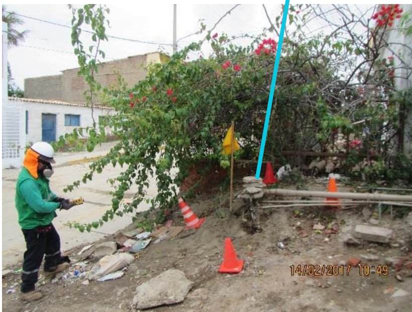
Pozo petrolero con conexiones clandestinas de gas
