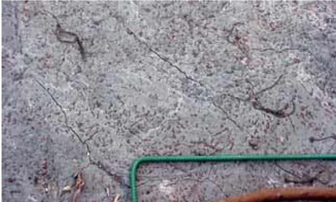
*Agrietamiento térmico severo en la superficie superior de una cimentación (Fuente: J. Gajda et E. Alsamsam, « Engineering Mass Concrete Structures », EEUU, p. 8, nov. 2006).*
