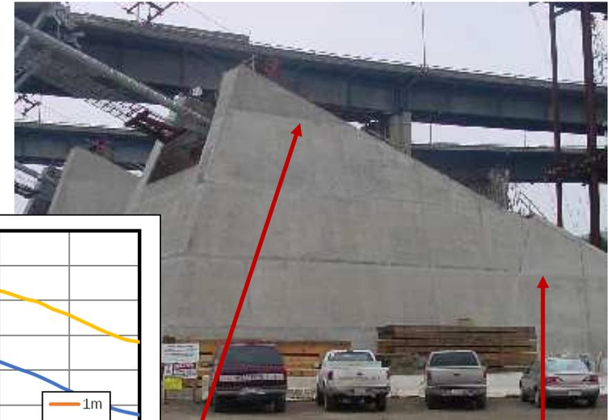
Secciones de vaciado
