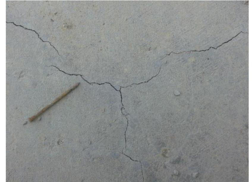
*Fisura por contracción térmica en losa de piso (Fuente: Moreno, A, « Qué es la retracción o contracción del concreto, como solucionarla y evitarla », Colombia, 2020).*
